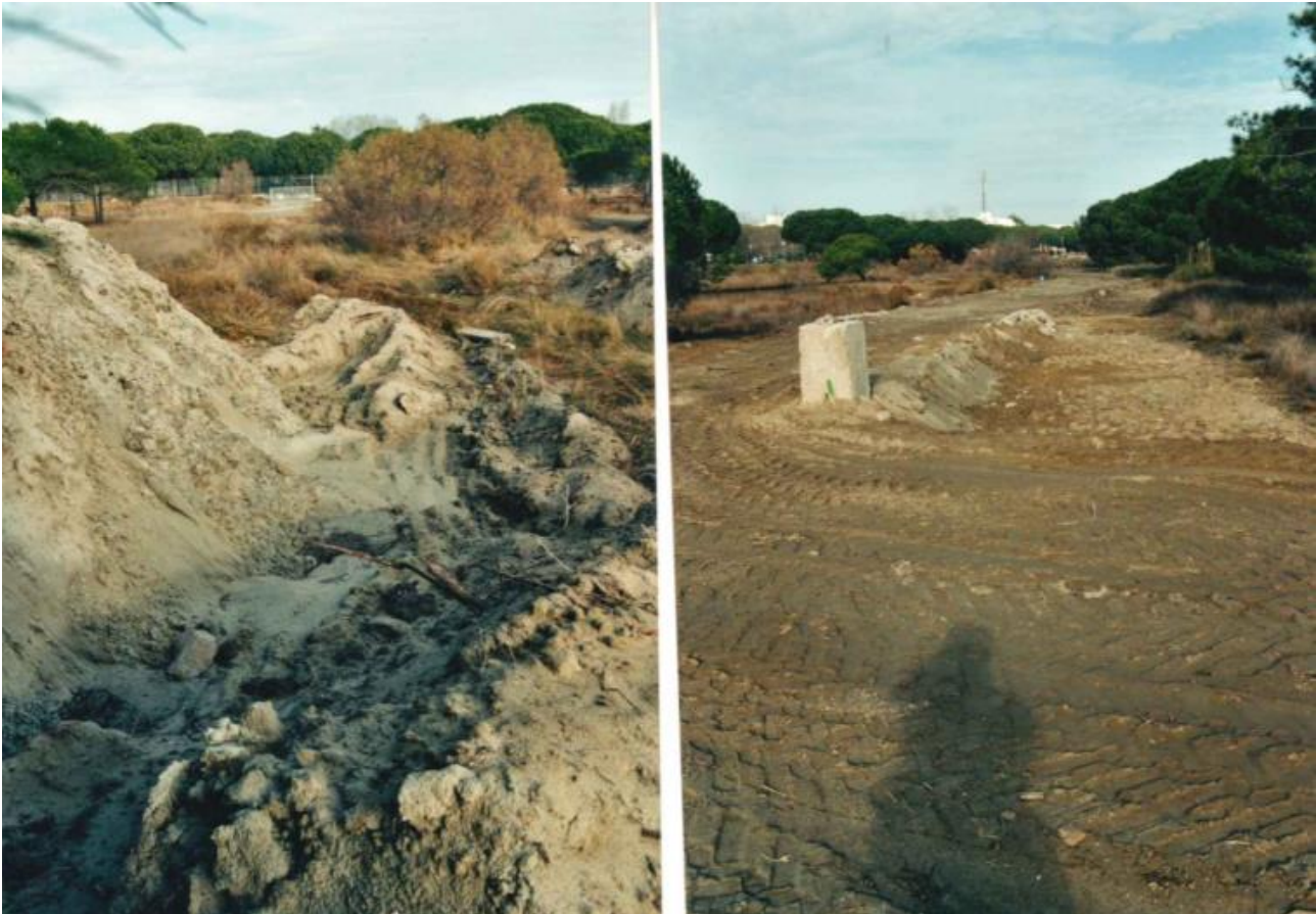
Photos 2 et 3 Janvier 2002 – travaux de remblai
